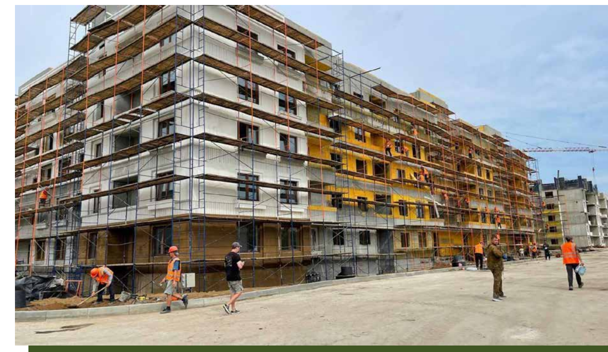
Работы по восстановлению российскими строителями города Мариуполя, разрушенного ВСУ. Август 2022 г.
